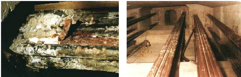
Abb. 2.3: Zustand eines Spannglieds im Bereich des Endquerträgers (links), gerissenes Spannglied der Überführung in Guildford (rechts)
