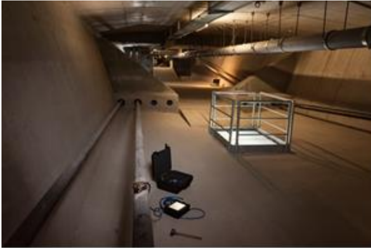
Abb. 2.1: Externe Spannglieder in der Pfinztalbrücke Nöttingen
